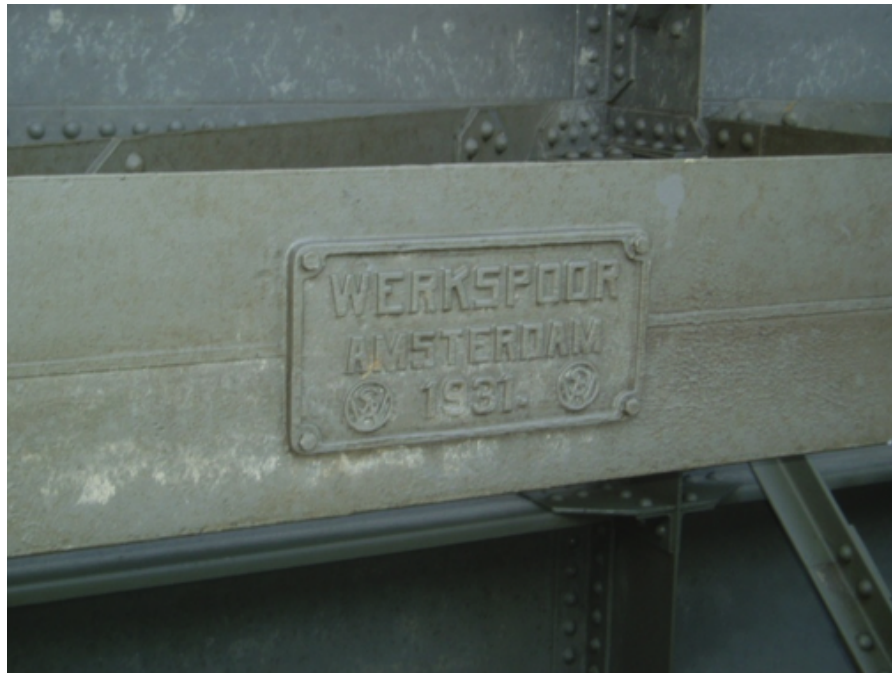
Figuur 1. De spuisluizen bij Den Oever stammen uit 1931.
