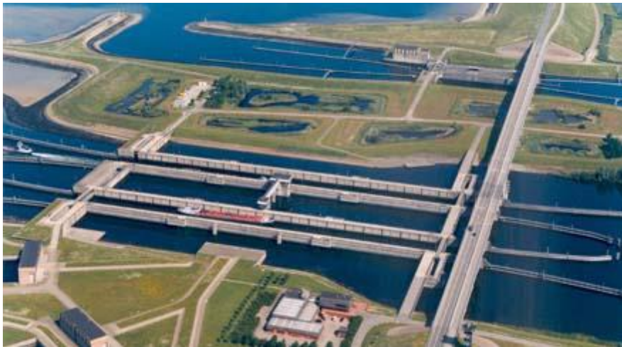
Figuur 4.5 De Krammersluizen
